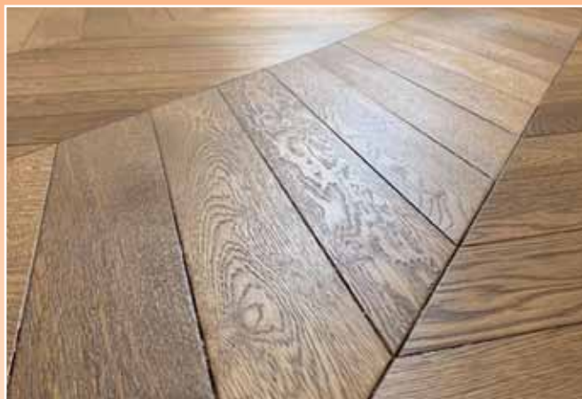
Slika 1: Primer složene i kvalitetne ugradnje: francuski slog – ševron ( Geddes Hardwood Flooring )
