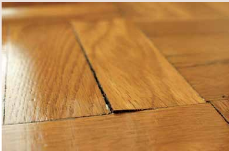
Slika 1: Deformacija na parketnom elementu kao posledica reakcije drveta i vlage
