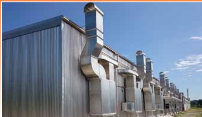
Rekuperatoski sistem u sušarama VKS/REK
