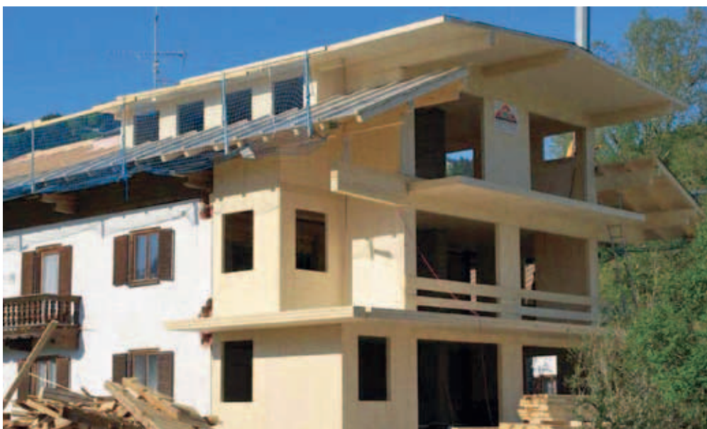
Slika 4: Dogradnja zidanog objekta objektom od CLT-a
