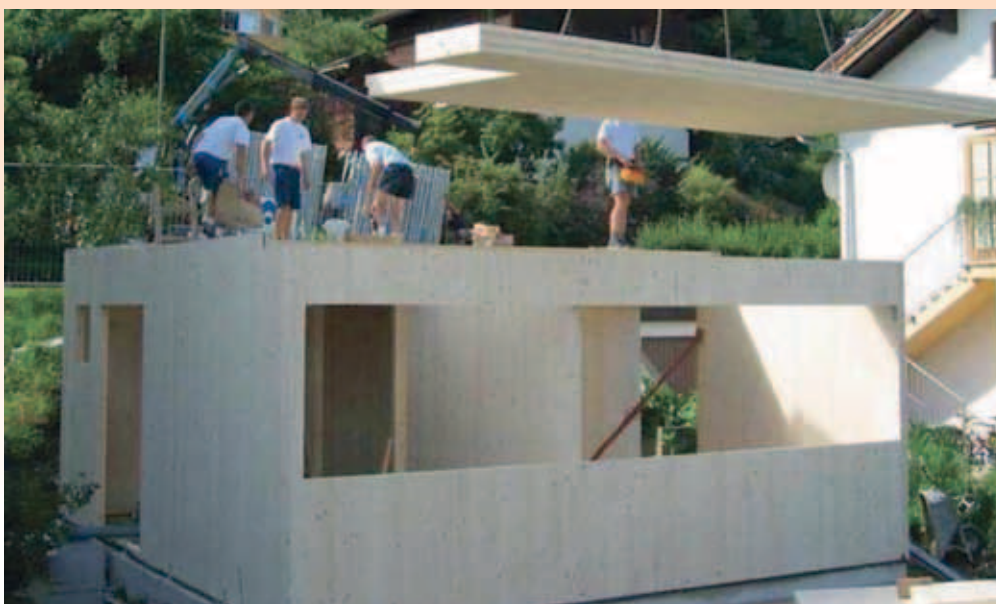
Slika 3: Konstrukcija malog objekta od CLT-a
