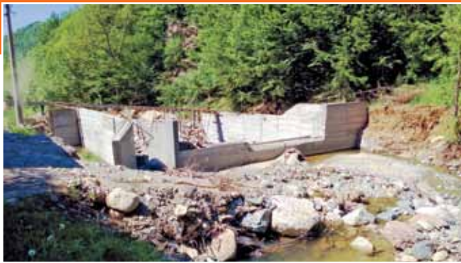
Vodozahvatna građevina i derivacioni cevovod u koritu Crnovrške reke (Park prirode "Stara planina"), april 2018.
