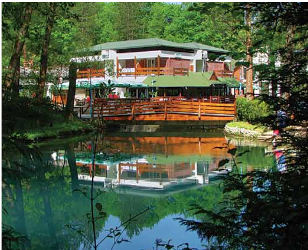
Pogled sa Vrela Mlave na drveni most i prvi deo Hotela Vrelo
