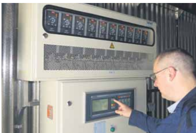
Automati i softver za vođenje procesa sušenja
