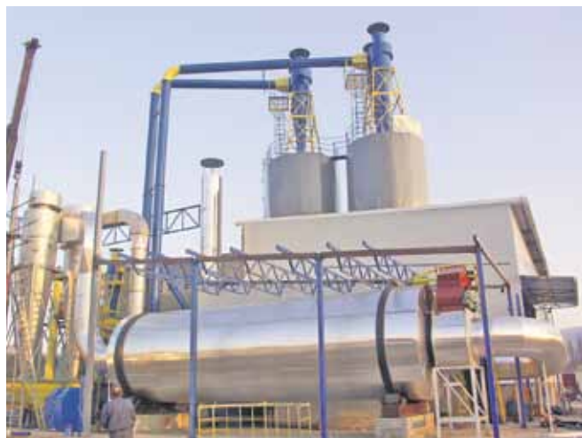
Fotografija 1 – Rotaciona (bubanj) sušara STON-ING na objektu u Banja Luci – instaliranje
