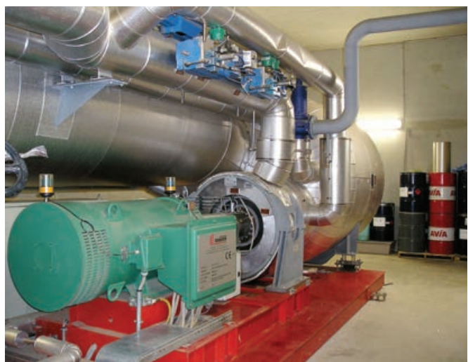
Generator, turbina i kondenzatora ORC uređaja
