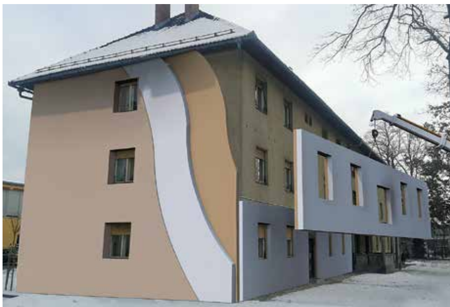
Slika 2. Oblaganje stambenog objekta prefabrikovanim drvenim CLT elementima (Fotografija kombinovana sa skicom: dr Bruno Dujč, CBD gradbeno in poslovno projektiranje d.o.)
