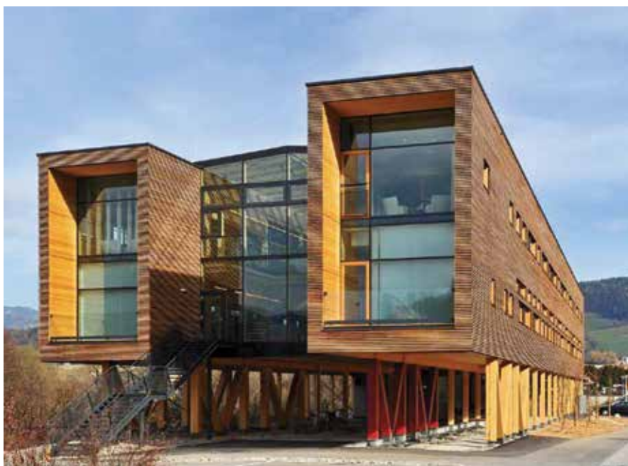
Slika 5. Primer kombinacije tradicionalnih građevinskih materijala i CLTa
