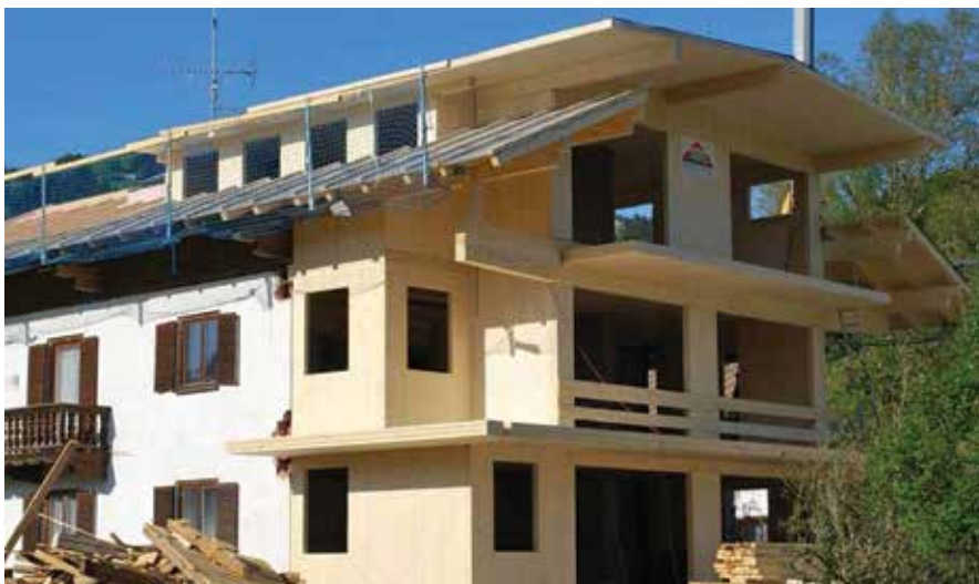
Slika 4. Dogradnja zidanog objekta objektom od CLTa
