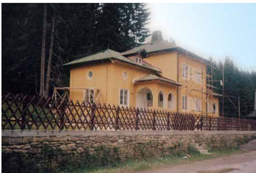
Vizitorski centar Parka prirode na Goliji, u toku izgradnje
