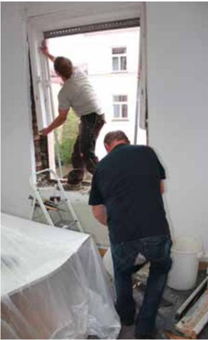
Demontaža starog dvostrukog prozora prozora sa kutijom
