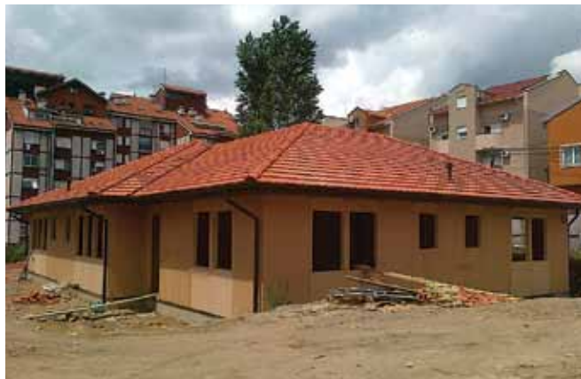
Denkova Bašta, vrtić u izgradnji
