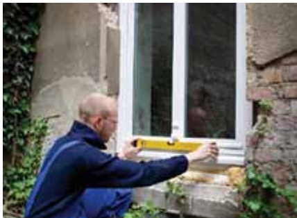
Zamena prozora na zaštićenim stambenim zgradama
