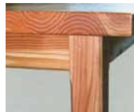
Slika 5: Primena ploče od zvezdastih lamela za stolove
