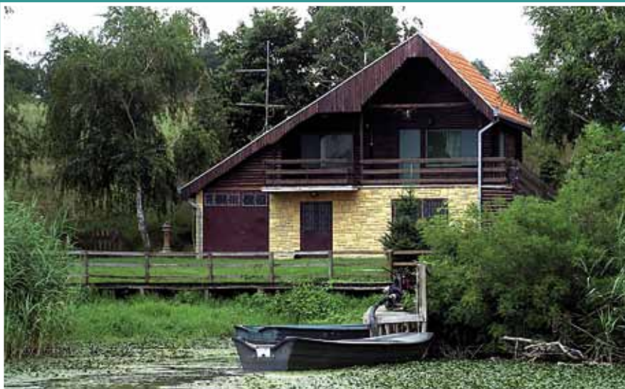
Lovačka kuća MARINA, lovište DONJE PODUNAVLJE
