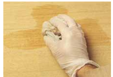
Slika 6. Temeljno pranje površine čistom vodom
