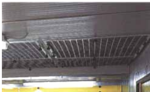
Slika 4. Filterska ploča – uređaj za dovod svežeg vazduha u kabini za lakiranje sa nadpritiskom (Barucca)
