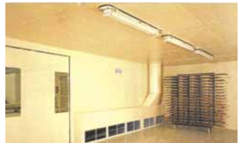
Slika 5. Zona za sušenje u komori za lakiranje sa nadpritiskom (Rippert)
