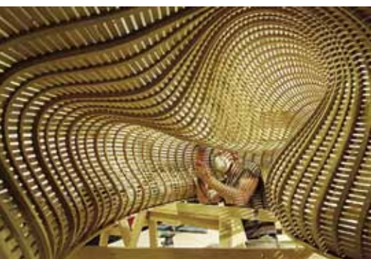
Povezivanje vertikalnih nosača horizontalnim elementima
