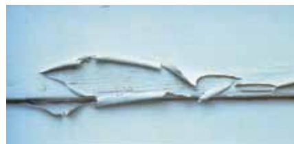
Ljuštenje između slojeva je obično posledica loše pripreme podloge
