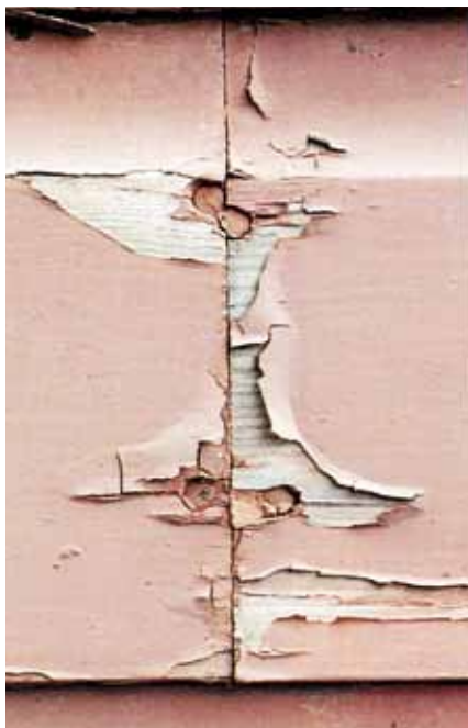
Pigmentirani premazi inicijalno propadaju na krajevima dasaka, zbog čega je neophodna njihova zaštita
