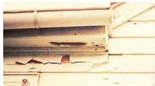
Propadanje pigmentiranih premaza zbog spoljašnjeg vlaženja
