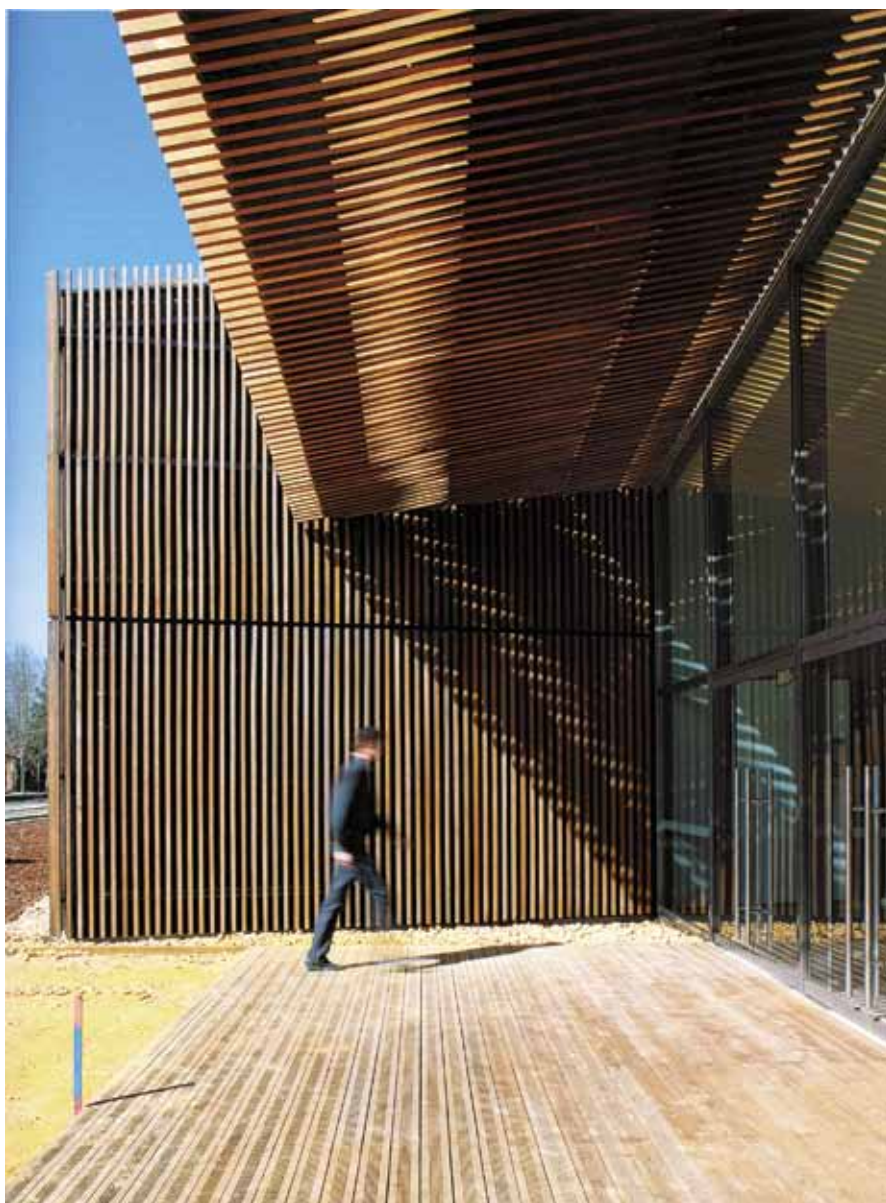
Velika streha kao konstruktivni metod zaštite drvene fasade
