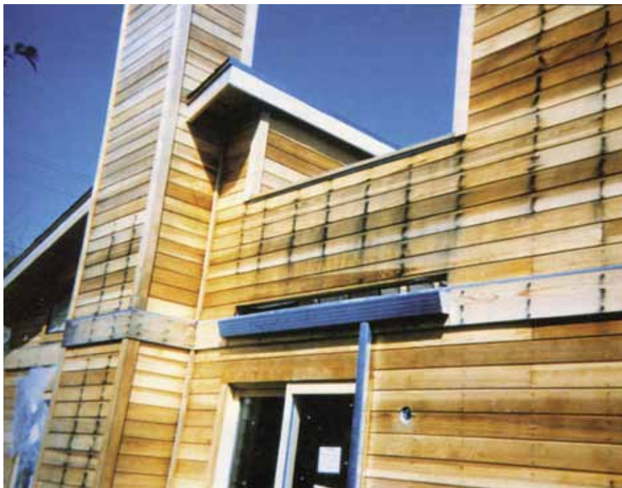
Plavo-crna diskoloracija nastala zbog eksera neotpornih na koroziju
