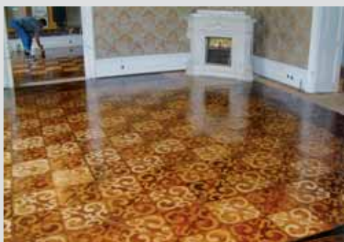
Postupak furniranja površine sa ručno sečenim segmentima od takozvanih drvenih pločica – BLIND FURNIR (debljina furnira oko 8mm)
