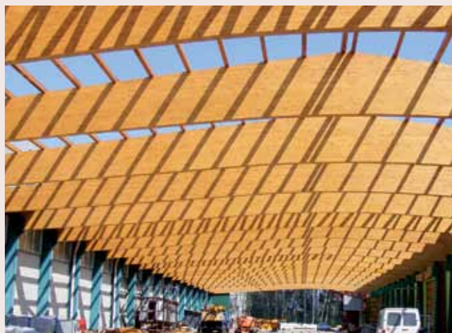
Krovna konstrukcija na objektu u Bačkoj Palanci
