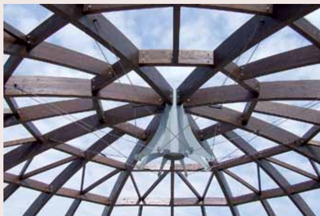
Krovna konstrukcija na objektu u Beogradu
