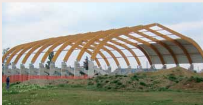
Krovna konstrukcija na objektu u Grockoj
