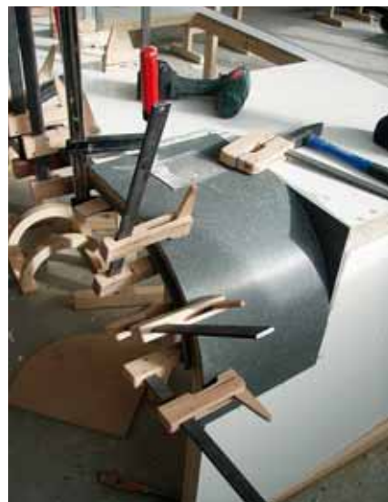
Lepljenje na drvenu podkonstrukciju
