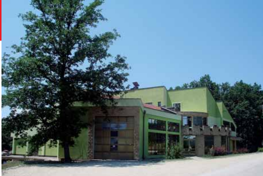
Poslovni objekat firme TOJO u Požegi
